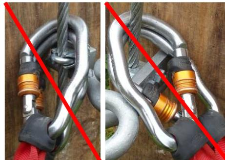
Dans les sections horizontales, le câble est simplement fixé au moyen d'un serre-câble au-dessus de la plaquette de fixation. Un câble horizontal tendu au maximum est « confortable » pour le ferratiste, mais dangereux au niveau sécurité. L'angle du câble soumis à une traction verticale entre 2 points d'ancrage successifs devrait être compris entre maximum 170 et 172 °, ce qui correspond déjà à une traction
